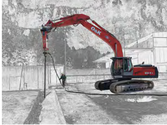
Raupenbagger mit Hydraulikhammer
